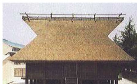
復元された5世紀の大きな倉庫
